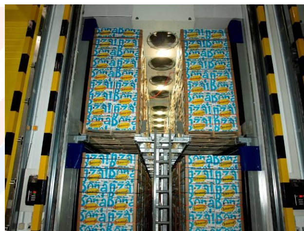
Chłodnice powietrza Thermofin seria X-TEDN w dojrzewalni z poduchami powietrznymi.
